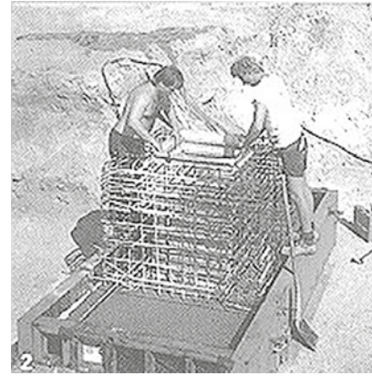
2. Der Schalungsköcher wird ca. 2 - 3 cm in den Frischbeton eingedrückt.
