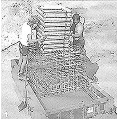
1. Die Bewehrung ist eingebaut. Der Schalungsköcher steht zum Einbau bereit. Die Fundamentplatte ist frisch betonierte. Der Köcher wird in die Bewehrung eingeführt
